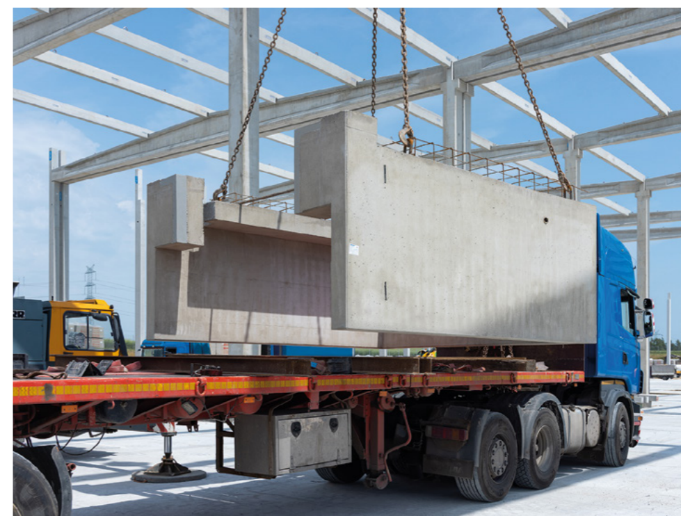
← MONTAŻ: Rozładunek i montaż doku "z auta".
