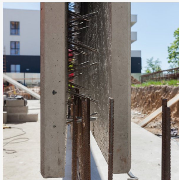
↑ MONTAŻ Proces montażu ściany zespolonej na wytykach startowych.
