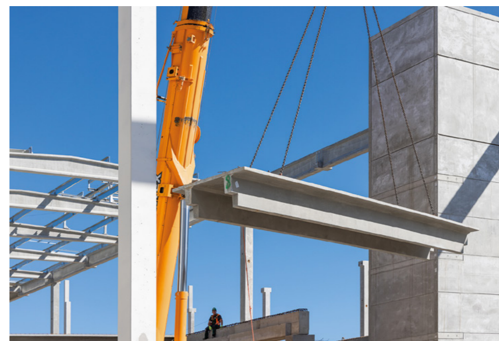
← MONTAŻ Montaż sprężonej płyty stropowej TT za pomocą dźwigu samojezdnego.
