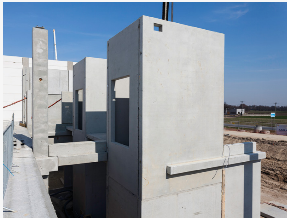
← MONTAŻ Montaż prefabrykowanego szybu windowego o konstrukcji skrzynkowej.
