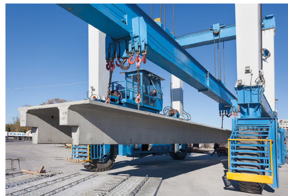
← PRODUKCJA Transport płyty stropowej TT za pomocą suwnicy bramowej samojezdnej.
