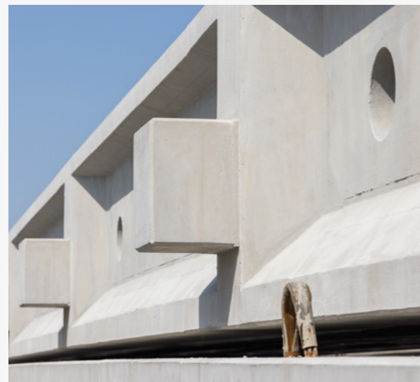
↑ DETAL Wsporniki wymianów, służące do podparcia dźwigarów.
