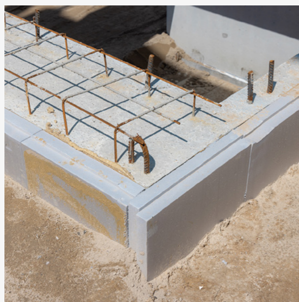
↑ MONTAŻ Zamontowany dok z wystającym zbrojeniem.
