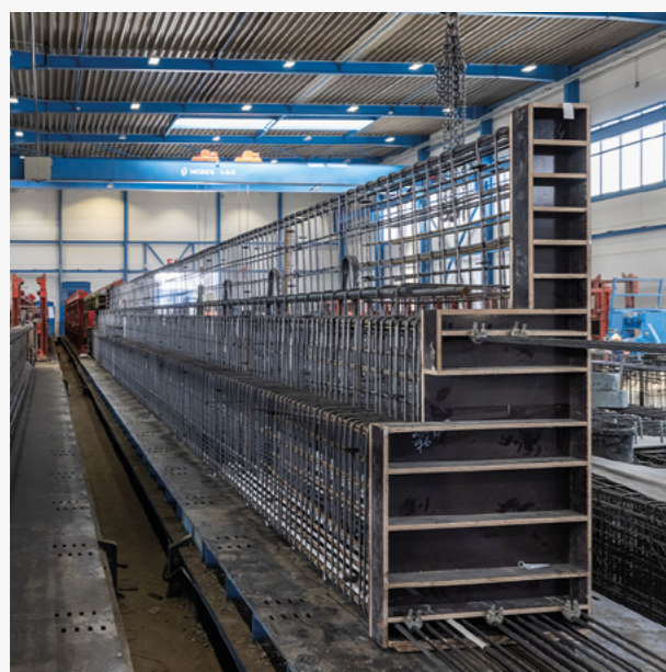
↑ PRODUKCJA Przygotowane zbrojenie belki sprężonej o przekroju schodkowym.
