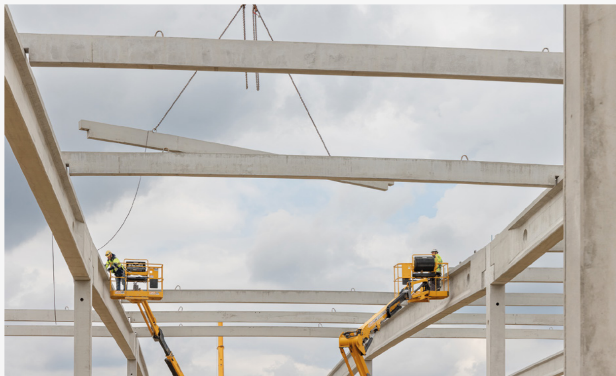
↑ MONTAŻ Montaż sprężonych płyt dachowych na prefabrykowanych dźwigarach jednospadowych.
