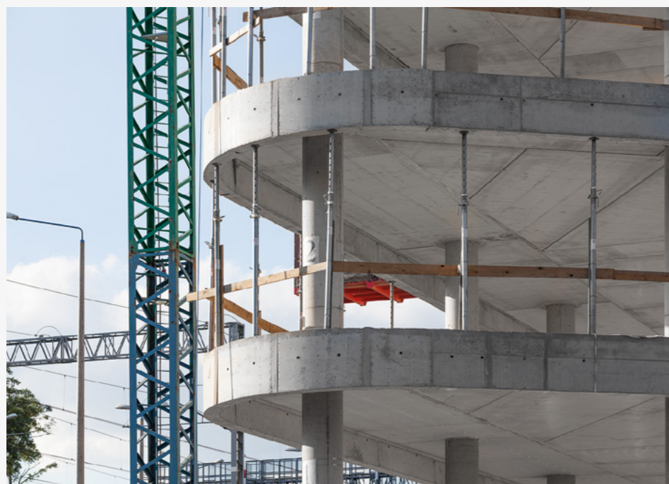
→ MONTAŻ Płyty stropowe filigran dostosowane do geometrii obiektu.
