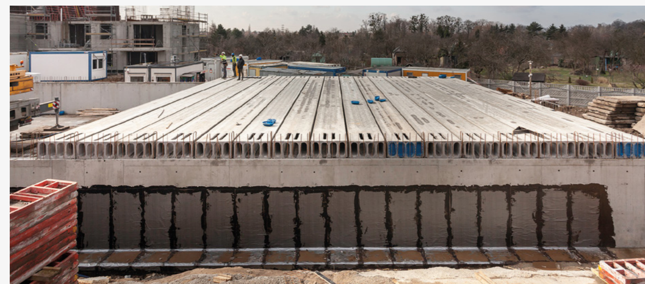
↑ MONTAŻ Strop wykonany ze sprężonych płyt kanałowych HCU 500 o długości 16 m.
