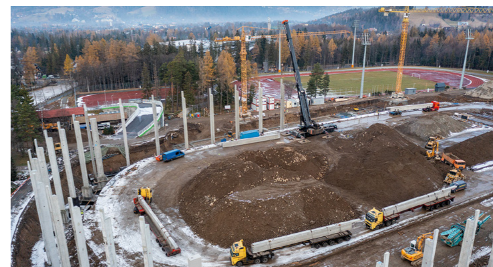
← REALIZACJA Centralny Ośrodek Sportu w Zakopanem. Montaż ponad 50-tonowych słupów o przekroju 1,5x0,9m.
