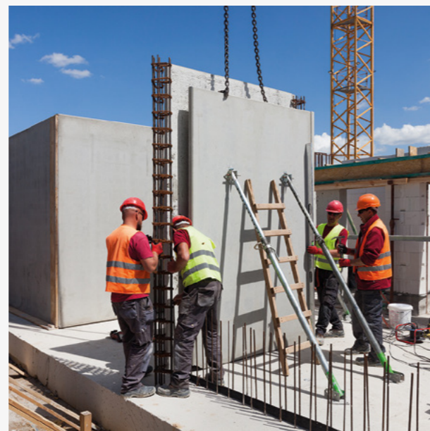
↑ MONTAŻ Montaż koszów zbrojeniowych w miejscu połączenia ścian zespolonych.
