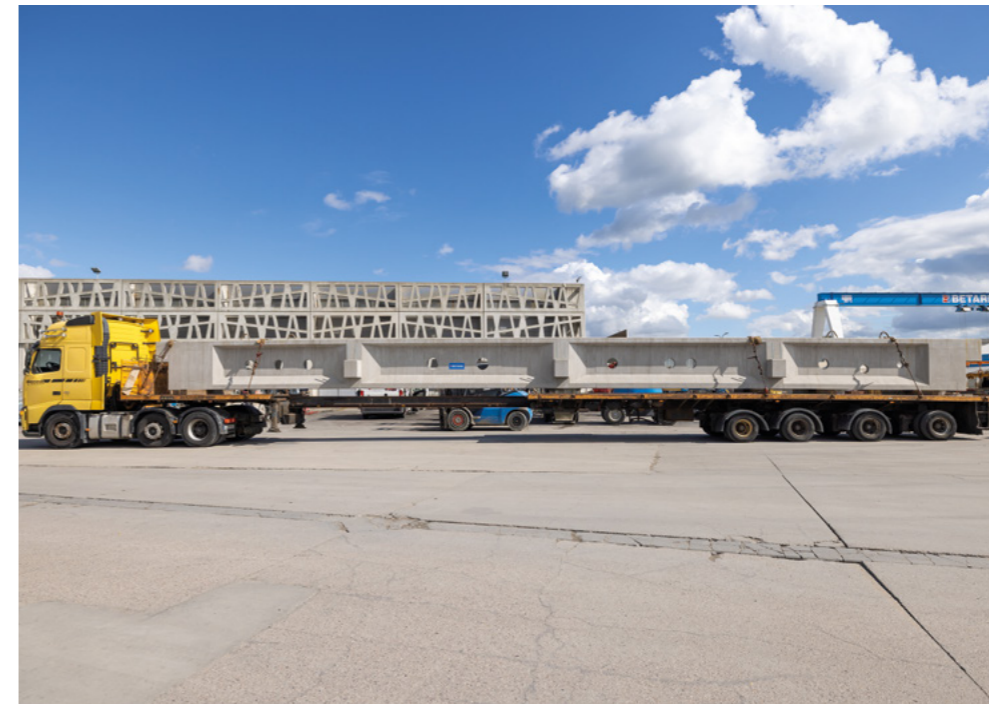
← TRANSPORT Transport sprężonego wymianu dachowego z 6-cioma wspornikami.
