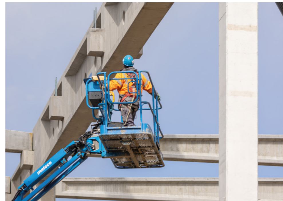
← MONTAŻ Montaż wielowspornikowego wymianu dachowego.
