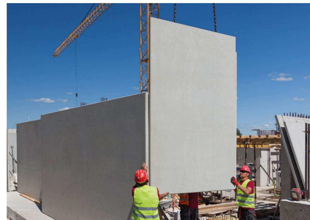
← MONTAŻ Montaż ściany zespolonej na przygotowanym podłożu za pomocą dźwigu samojezdnego.
