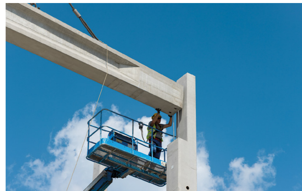
← MONTAŻ Montaż dźwigara sprężonego na wytykach słupowych.
