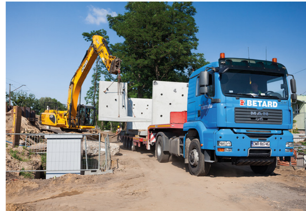
← TRANSPORT Rozładunek ścian oporowych za pomocą dźwigu samojezdnego.
