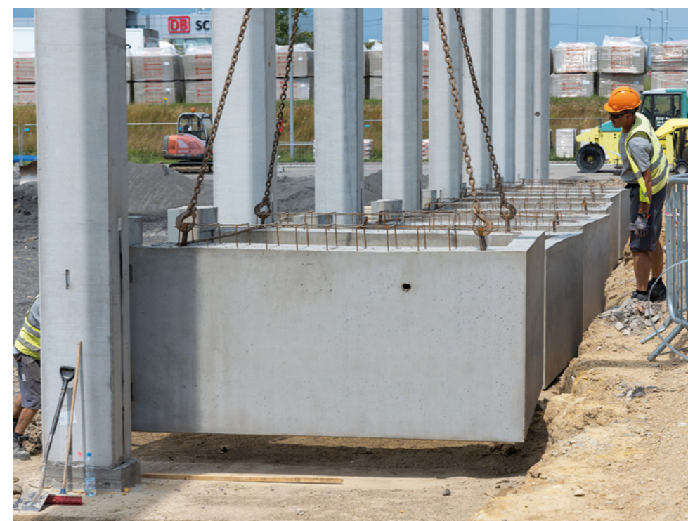
← MONTAŻ: Montaż doku na wcześniej przygotowanym podłożu.
