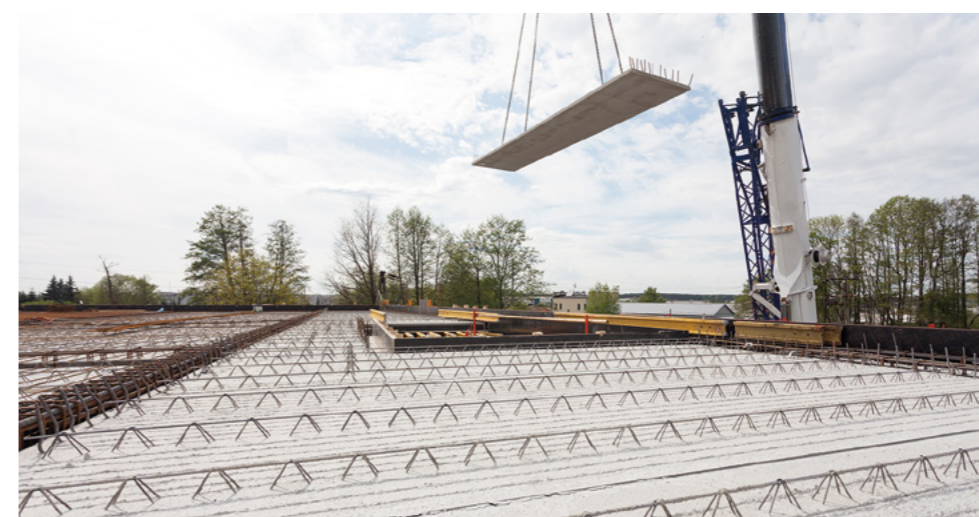
← MONTAŻ Montaż płyty stropowej filigran za pomocą dźwigu samojednego.
