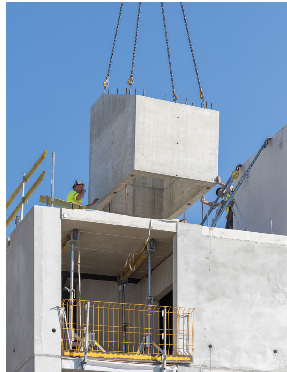
← MONTAŻ Montaż elementu skrzynkowego szybu windowego.
