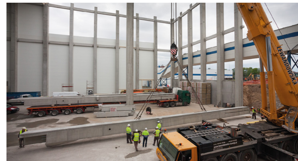
← MONTAŻ Montaż ponad 80-tonowych słupów o przekroju 1,1x1,1 m.
