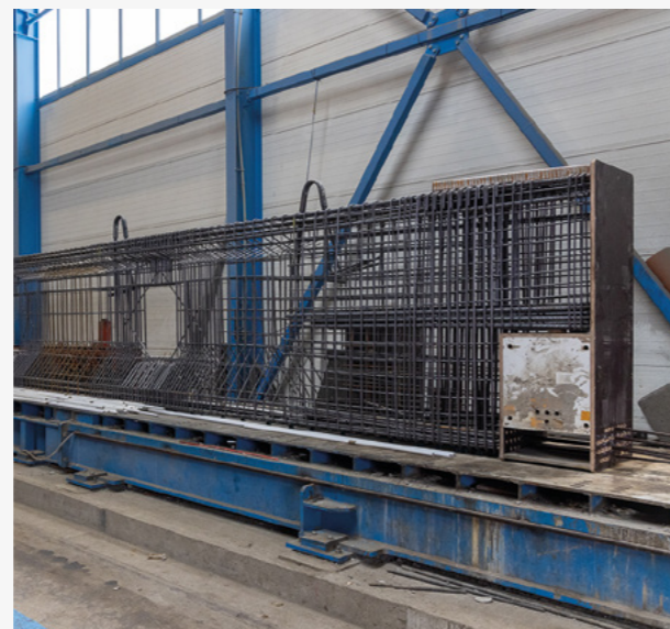
↑ PRODUKCJA Kompletne zbrojenie elementu ułożone na stole naciągowym.
