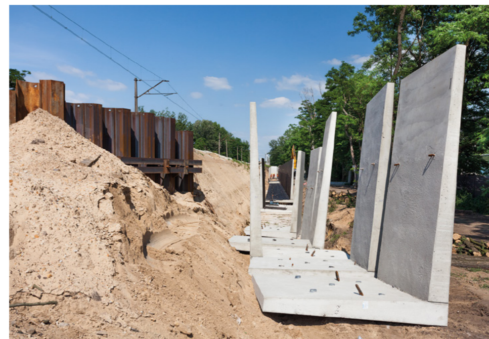
← MONTAŻ Ściany oporowe przygotowane do ostatecznego etapu montażu.
