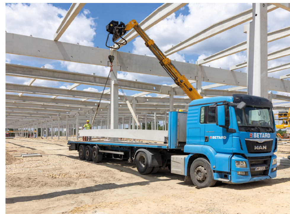
← TRANSPORT Rozładunek transportowanych sprężonych płyt dachowych.
