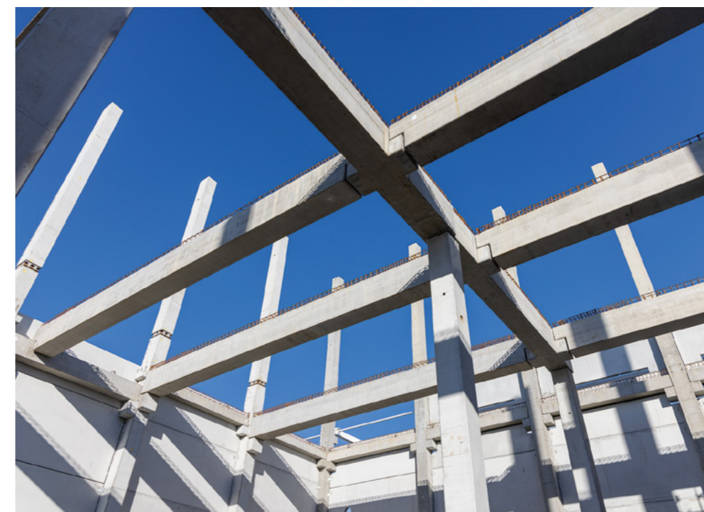
← MONTAŻ Szkieletowa konstrukcja obiektu z zastosowaniem prefabrykowanych słupów i belek sprężonych.
