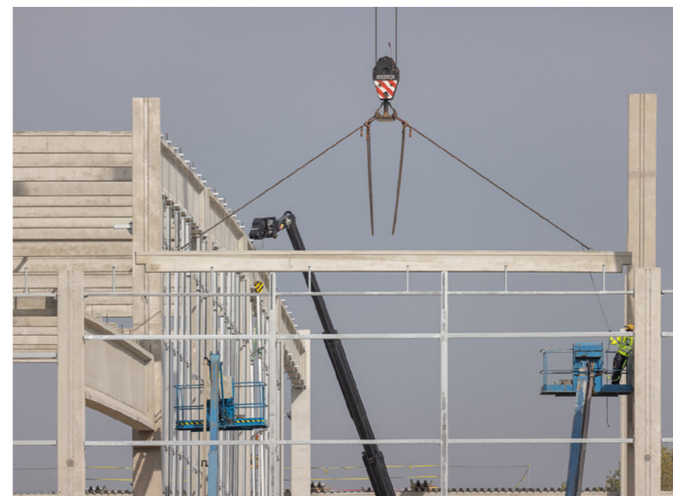
← MONTAŻ Montaż sprężonych płyt dachowych z podcięciami w miejscach podparcia.
